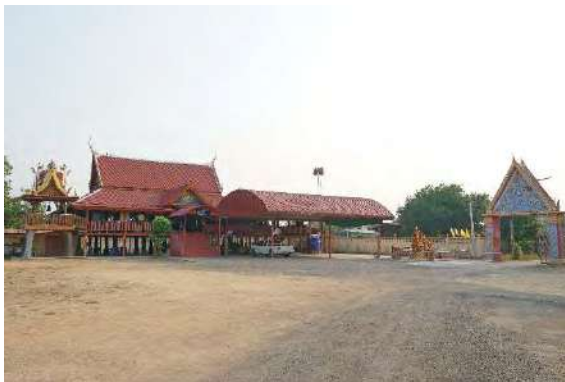
ศาลาการเปรียญกว้าง 16 เมตร ยาว 19 เมตร สร้าง พ.ศ.2525 ได้ถูกย้ายมาตั้งยังที่ปัจจุบันพร้อมยกใต้ถุนให้สูงขึ้นเพื่อเพิ่มพื้นที่ใช้งาน
